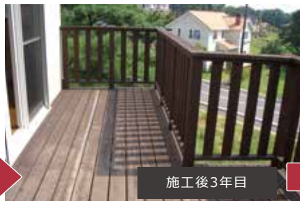
2年5ヶ月経過したウッドデッキ表面の様子（塗装品）
